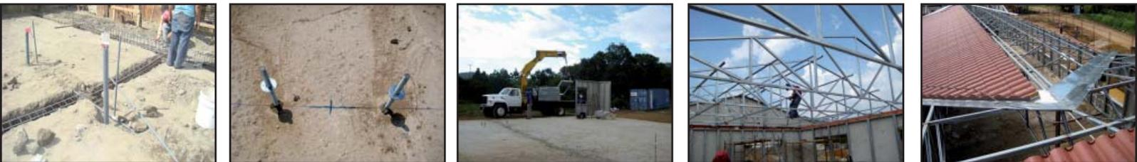
A continuación, se realiza el montaje de la cubierta con cerchas y correas. Sobre las correas se montan los paneles de cubierta tipo sandwich de espesor y tipología elegidos.
